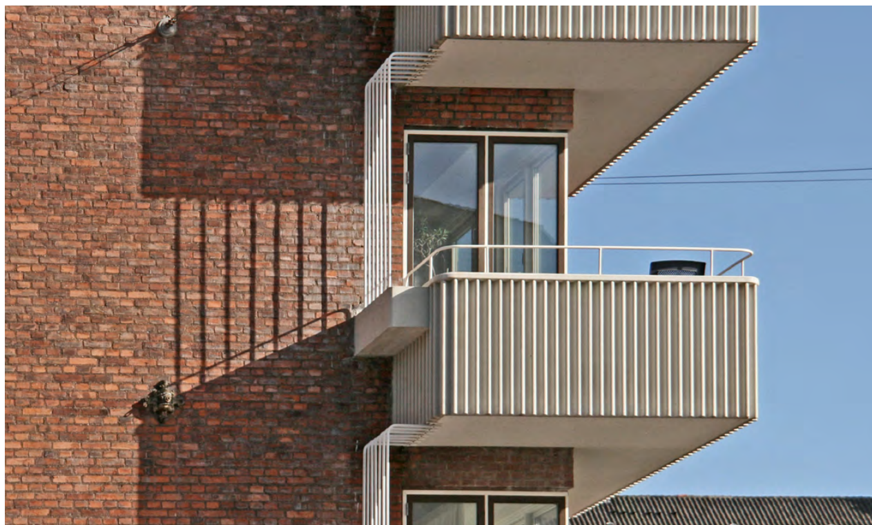
Torvegade 57 Smukt restaureret oprindelig altan, der harmonerer med vinduet.
