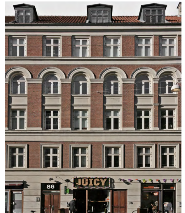
Istedgade 86 Kombinationen af de meget markante rundbuer og gesimsen over dem gør det udfordrende at opnå en god helhedsvirkning med altaner på 4. sal.
