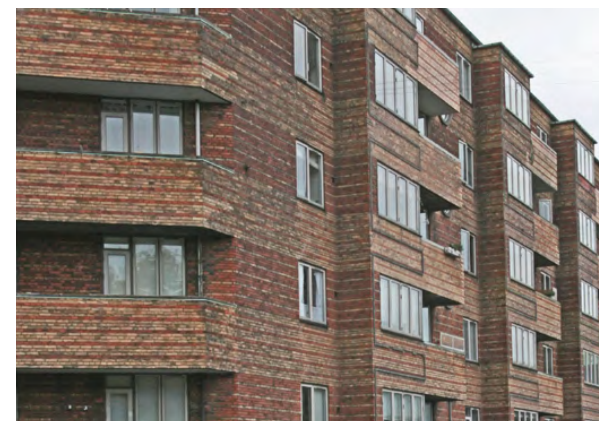
Sankt Kjeldes Plads 5 Oprindelige murede altaner der følger vinduesbåndene som et centralt motiv på facaden.
