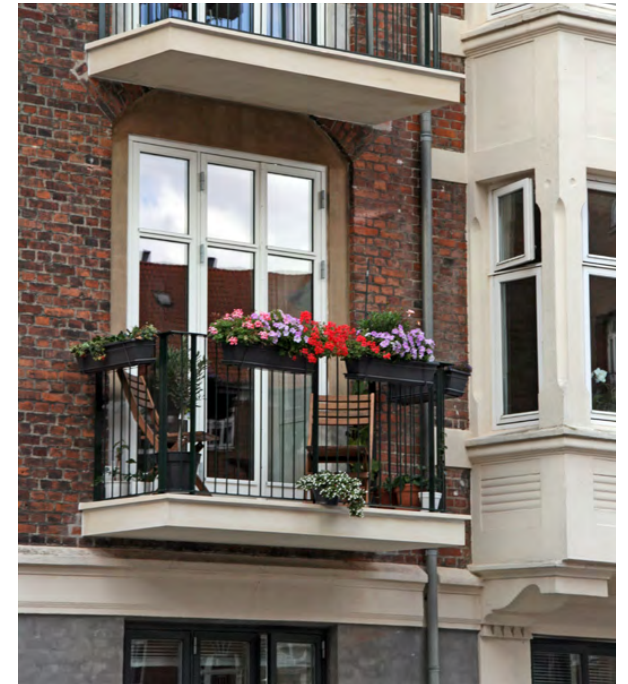
Bevtoftegade 2 Altanen er tilpasset til dybden af karnappen og holder en respektafstand til karnappen, der svarer til dybden. Bunden har en detaljering og stoflighed, der harmonerer med karnappen.
