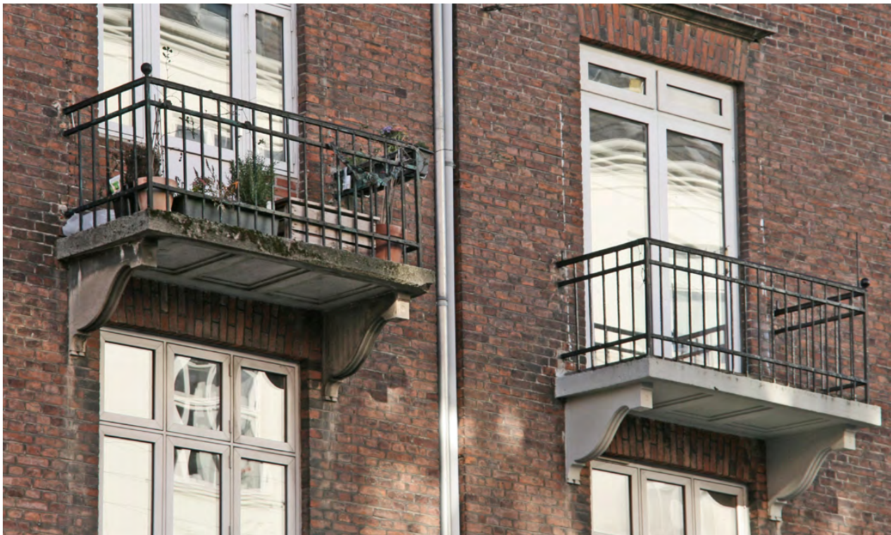
Sommerstedgade Restaureret oprindelig altan.
