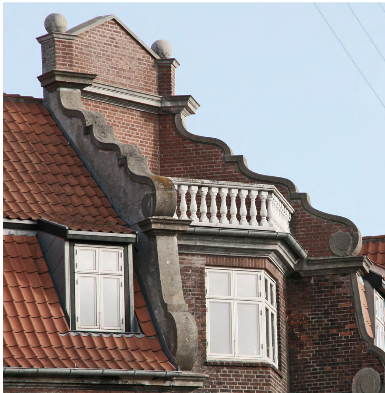
Snorregade 7 Oprindelig tagterrasse i mansardtag.
